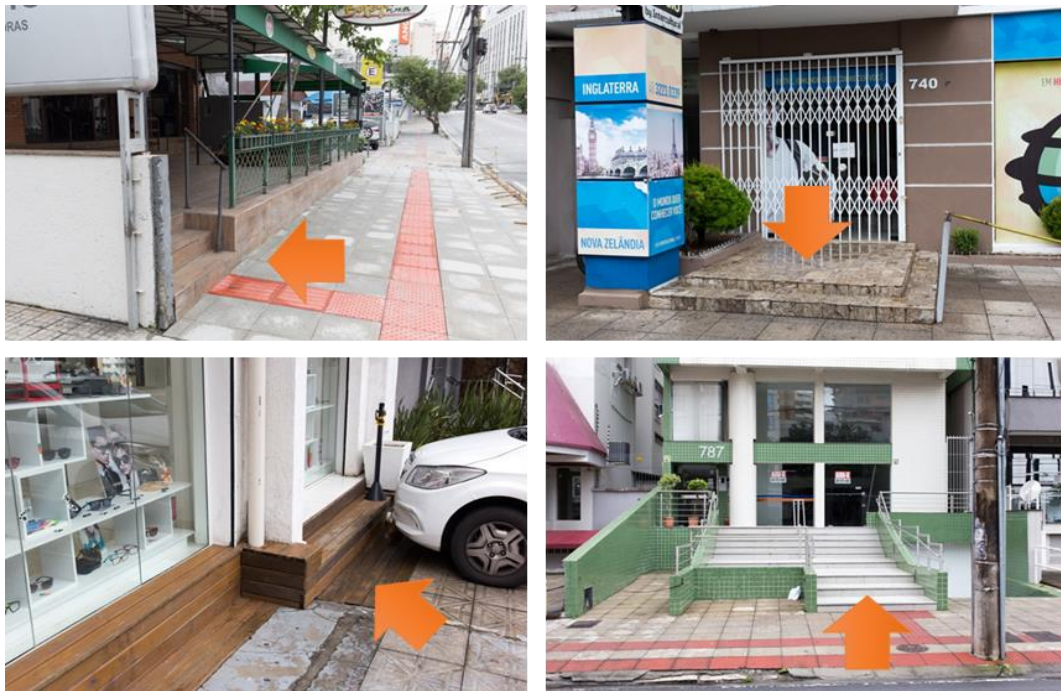
Figura 4. Avenida Rio Branco: Estabelecimentos Comerciais Sem Acessibilidade
